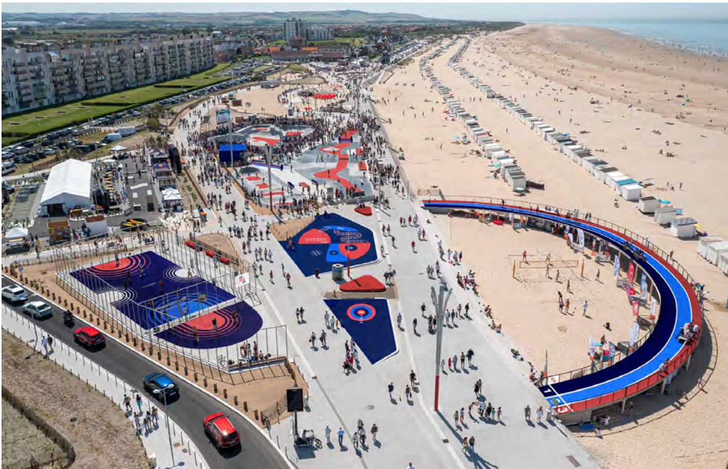
Projet de rénovation du front de mer de Calais Credits : Ville de Calais © Fred Collier
